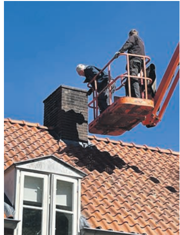
Inspectie en reparatie van een schoorsteen.
